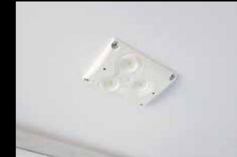
**LED-Beleuchtung innen:** Eingelassene Deckenleuchten ohne Schalter, mit Steuerung über PIR-Sensor mit Zeitschaltung (10'). Extrem langlebige Lösung mit geringem Stromverbrauch.
