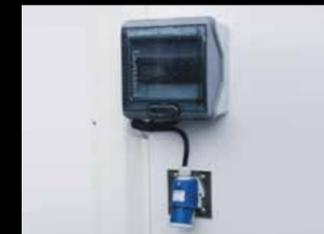
**Steuerung und Netzanschluss:** Die digitale Steuerung ermöglicht die Regelung der Soll-Temperatur und die Anzeige der Ist-Temperatur. Eine externe Steckdose mit Verlängerungskabel (8 m optional) dient zum Anschluss der externen Versorgung (Option) ans Netz 230V (mind. 16 A).
