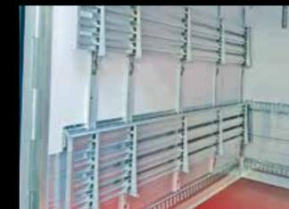
**Einstellbare und hochklappbare Regale (Option):** Es sind höhenverstellbare und hochklappbare Regale auf mehreren Ebenen und in 2 Tiefen (400 oder 500 mm) verfügbar. Die Regale aus 100% Aluminium (Antikorrosion) werden mit Anreißerbolzen in den gewünschten Höhen fixiert.
