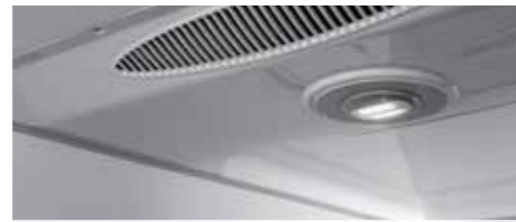
Éclairage intérieur LED
